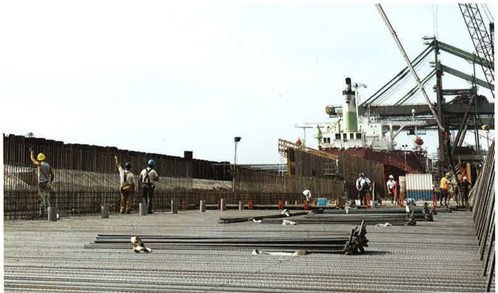
De prefab elementen van de kade worden vervaardigd met hogesterktebeton met staalvezels.
